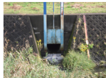
樋門・樋管の無動力化(御殿川の事例)
