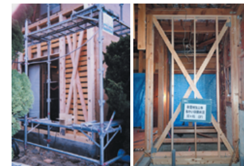
耐震補強工事(筋かい設置)の例
