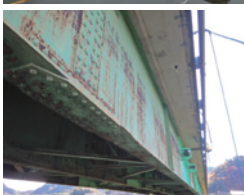
◀ 損傷状況 (主桁)
