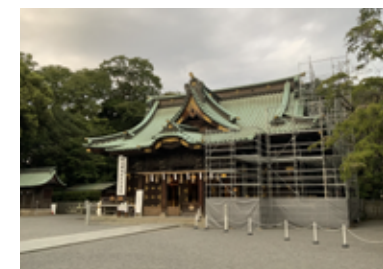
修理中の社殿
